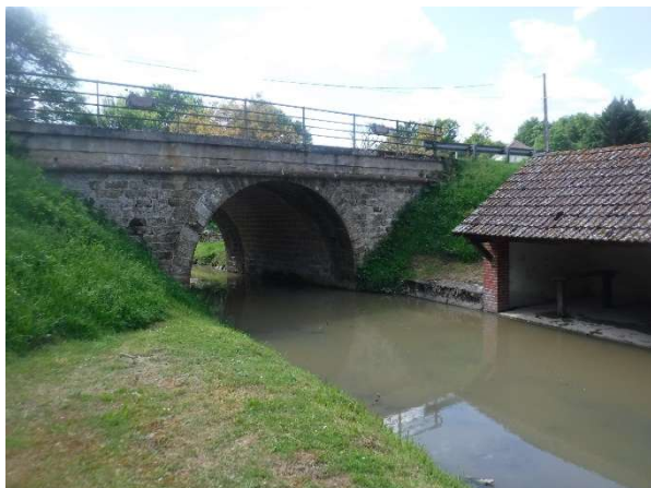
Pont sur le ruisseau de la Grange
