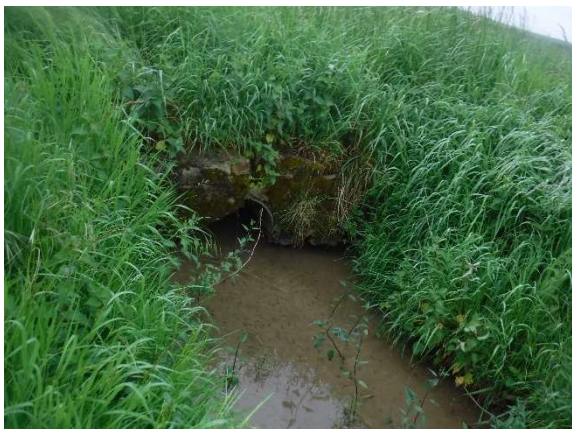
Colmatage sédimentaire sur la Molaine (dégradation forte des berges par les ragondins)
