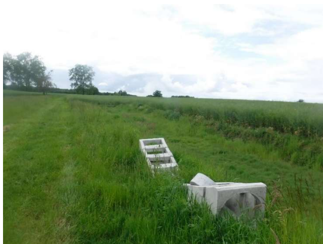
Zone humide tampon en sortie de drainage sur le ruisseau de Vare
