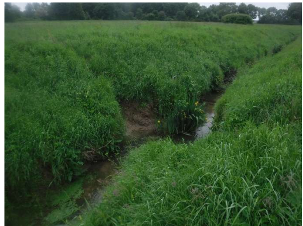
Passage fréquenté par la faune sauvage entraînant un effondrement de berge (Prée)
