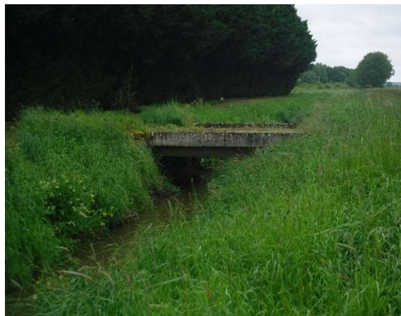
Passerelle engin sur la Prée
